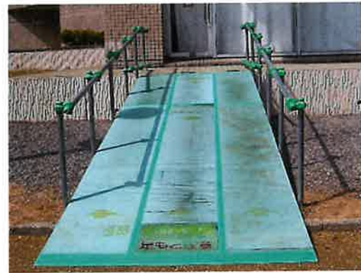
アケパーク仮設スロープ設置 (発注者：柏崎市)
