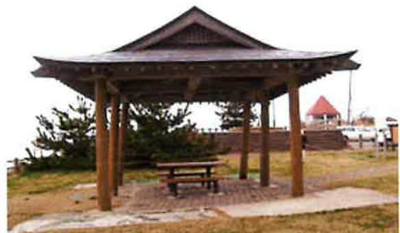
椎谷夕日が見える丘公園 あずま屋復旧工事 (下請)
